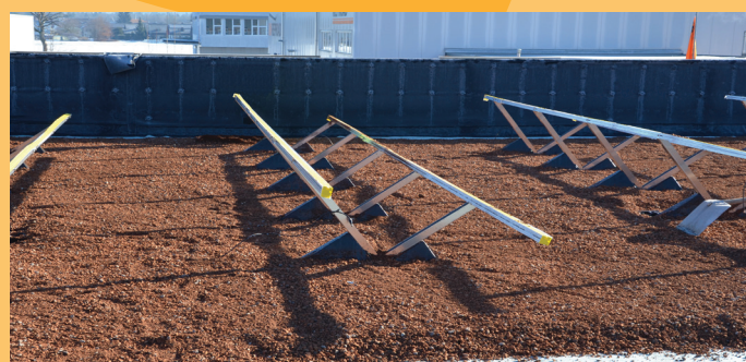
3. Substraat op de voorgeschreven hoogte aanbrengen.
