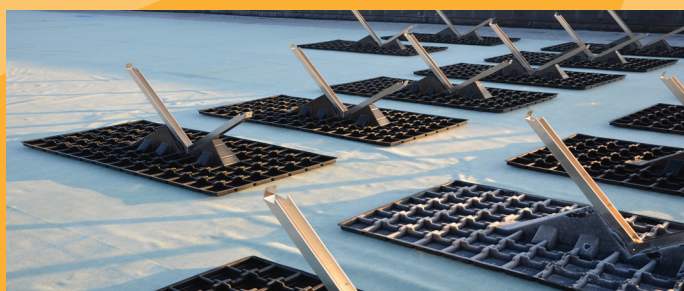
1. Knick-Fix hoek monteren en kunststof kuipen positioneren.
