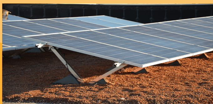
4. Panelen met montagehulpstukken vastzetten en kabels verbinden. Klaar!
